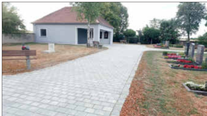
Leichenhalle und Zugang lobenswert saniert.
