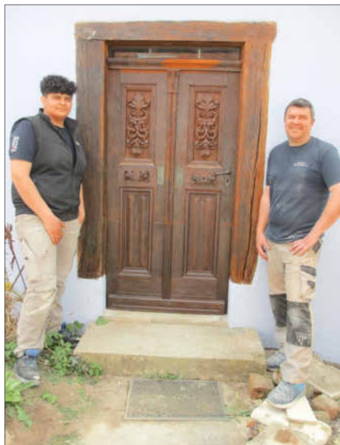
Restaurator Alexander Roscher (re.) und Azubi Ali Muhammad Ali nach dem Einbau der Eichentür.
