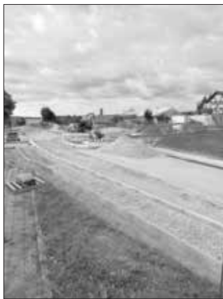
Anlegen der Fahrbahnbreite für den Übergang
