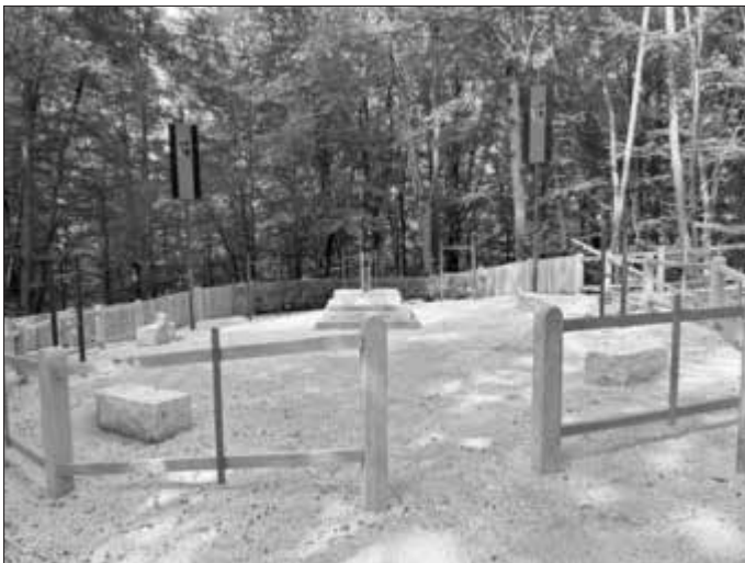
Zwischenzeitlich wurde der Zaun und das Kreuz montiert.
