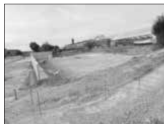
Die Parkplätze und der neue Radweg entlang der Gärtnerei Katzer sind im Bau. Hier werden 200 m Muschelkalksteine verbaut.
